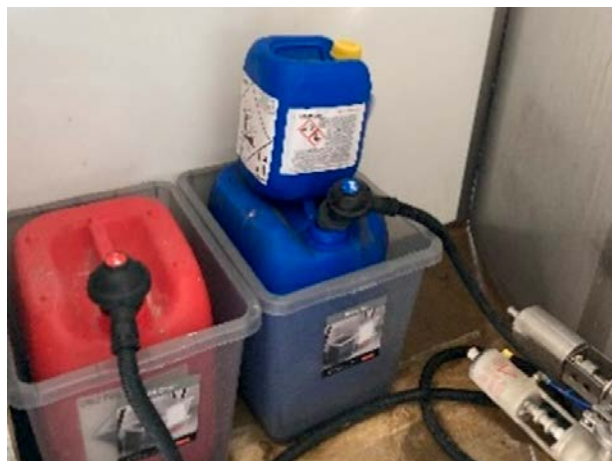
Diskmedelsdunkar placerade i plastlådor för att skydda golvet mot frätskador.
