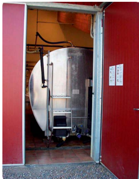
Entré till mjölkavhämtningsrummet med direkt anslutning till tankutloppet.
