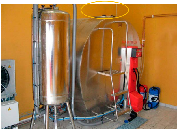
Manlucka (markerad med gul ring) med fri höjd till tak, i ett avhämtningsrum.
