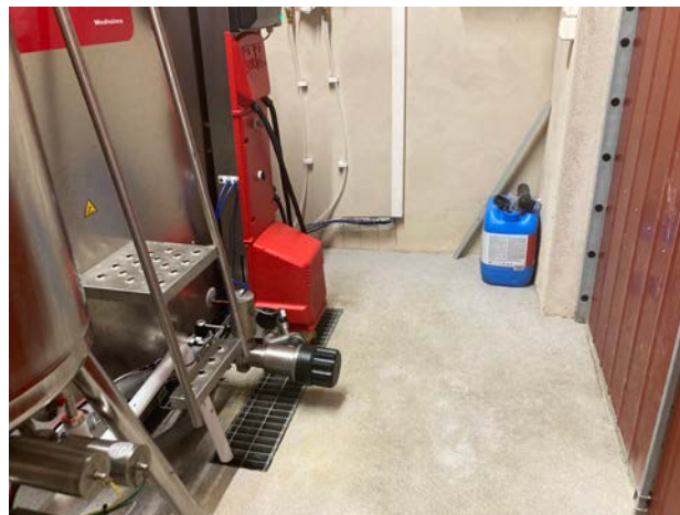
Främre delen av tanken, med utlopp för mjölkhämtning, har placerats i eget utrymme.
