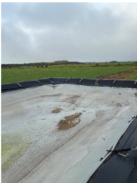
Flexibelt gödsellagringssystem
