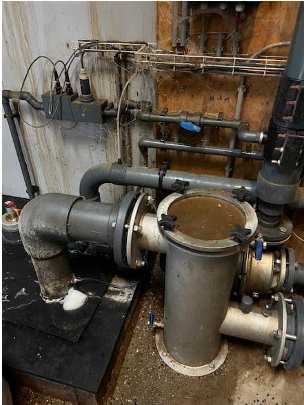
Biologiskt luftfilter för rening av frånluft
