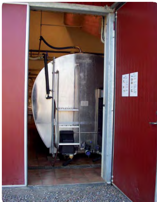
Ingång till mjölkhämtningsrummet med direkt tillgång till tankutloppet.
