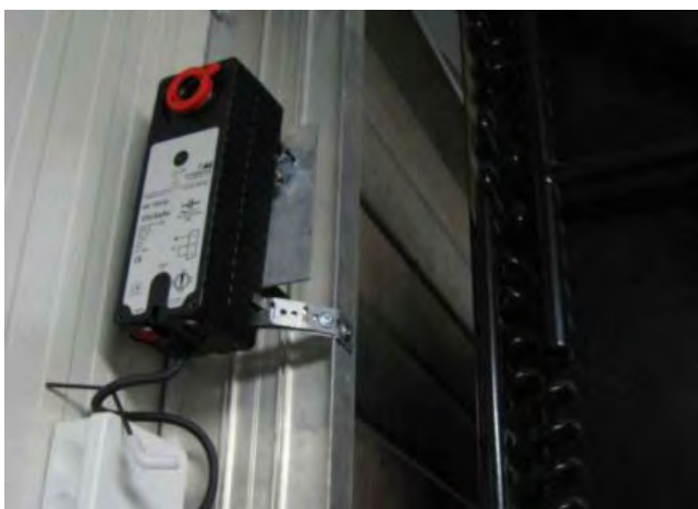
Jalusi spjället öppnas av en elektrisk motor efter impuls av en termostatstyrd fläkt eller t ex i samband med att kylningen startas
