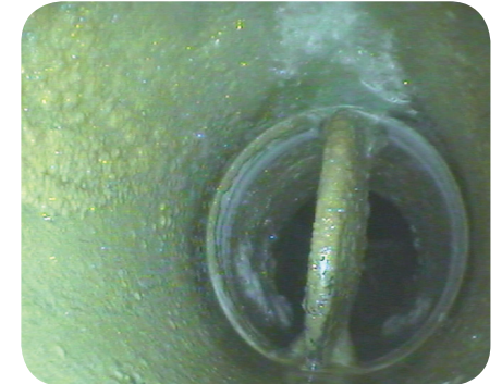
Beläggningar i rör efter disk
